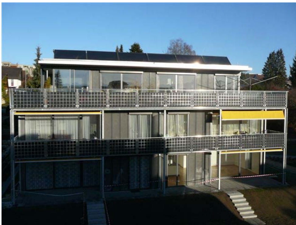
Fig. 7: Geländerintegrierte PV-Anlage
