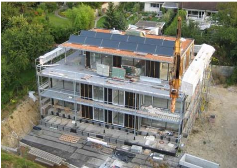
Fig. 6: Solaranlage mit 30 m 2 Kollektorfläche
