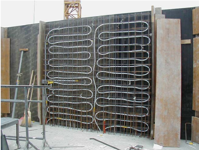
Fig. 1: SOLARIX-Kühlleitungen
