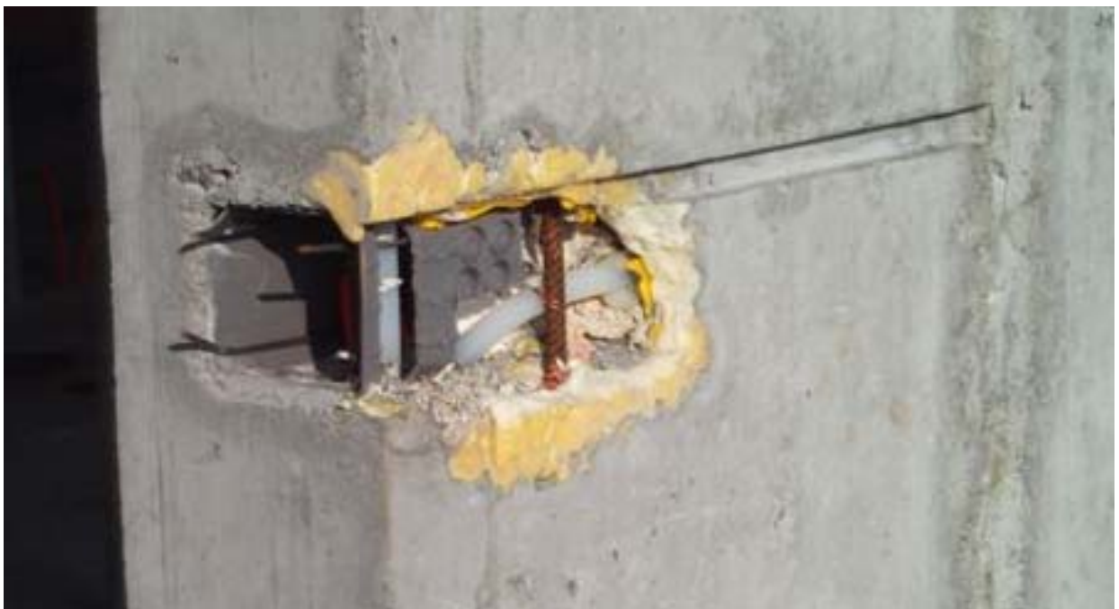
Fig. 3: Aussparung für Temperaturfühler zur Messung der Wassertemperaturen im Kühlregister, sowie der Oberflächentemperatur des Soraix-Wandelements.
