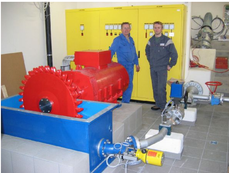
Die zufriedenen Monteure nach dem Befestigen des Laufrades. Das Wasser fällt von der Turbine in das darunter liegende Becken und gelangt nach der Ausgasung ins Reservoir. Unten im Bild der gelbe Düsenverstellmotor, dahinter der Kugelhahn.
