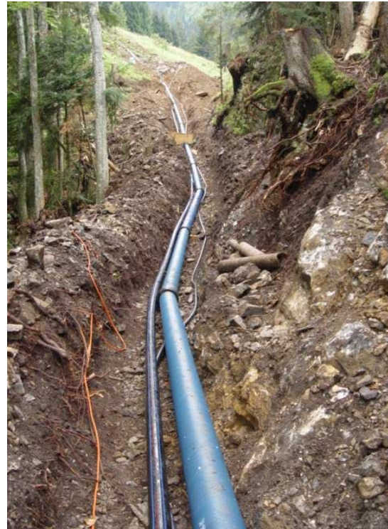
Polygonale Leitungsverlegung mit Steckmuffenrohren DN 200 mm, PN 25 bis PN 100
