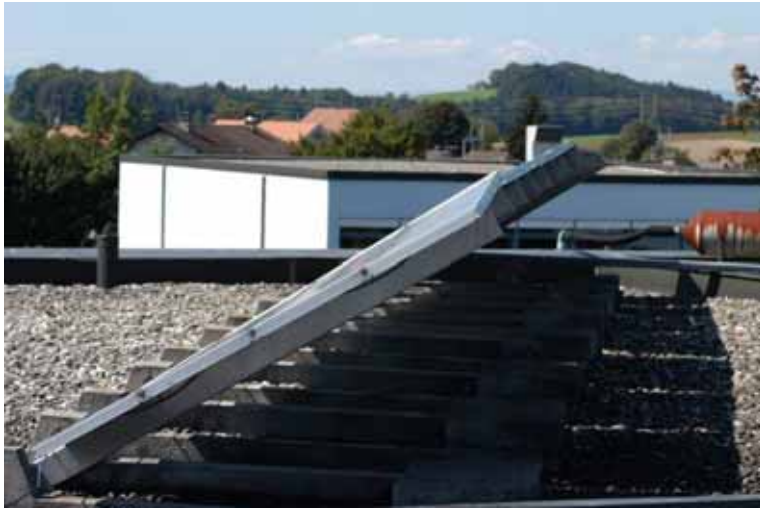
Abbildung 4-53: Betonsockel verschieben sich
