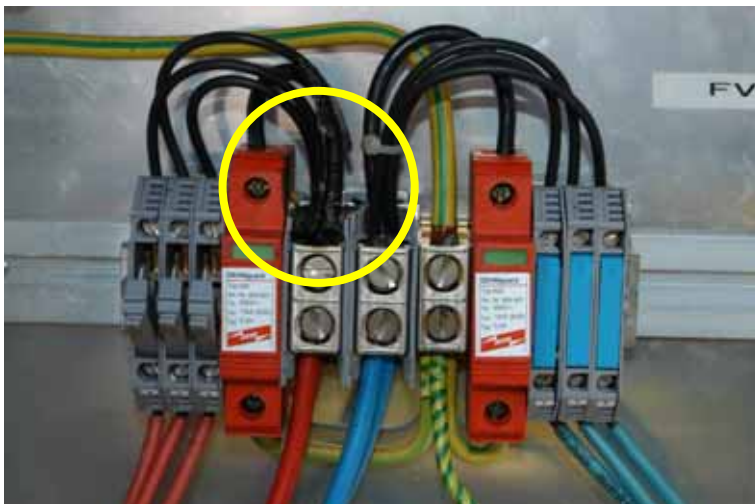
Abbildung 4-15: Verschmolzene Litzen im Feldanschlusskasten
