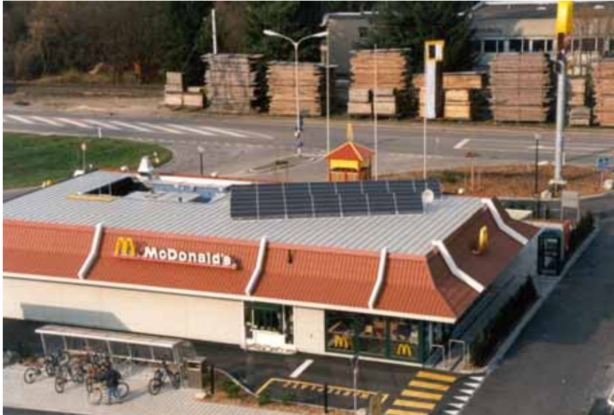
Abbildung 4-1: PV-Anlage auf dem McDonalds Gebäude
