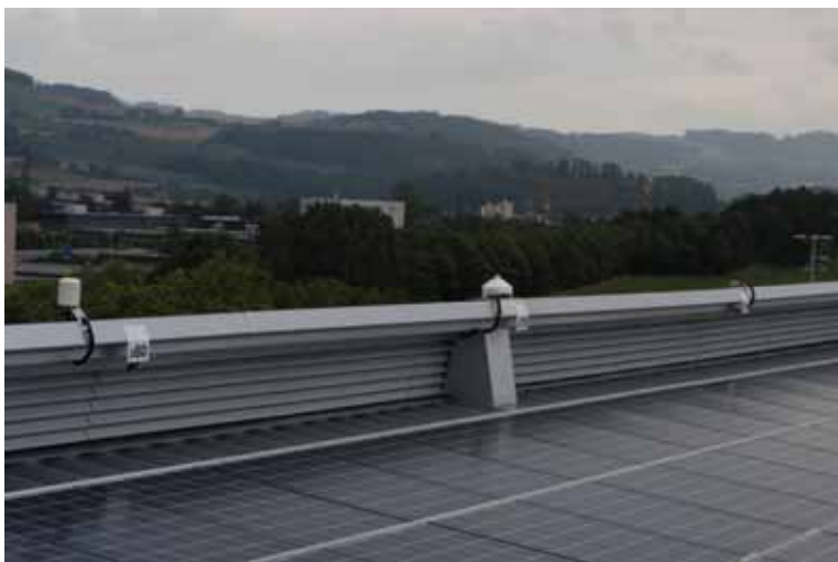
Abbildung 3-70: Position der Sensoren nach dem Umbau
