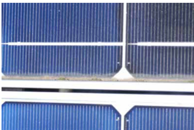
Abbildung 4-57: Verschmutzte Anlage
