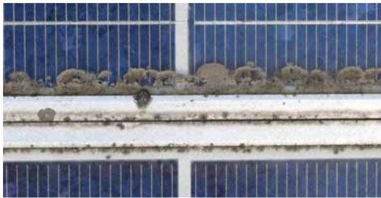
Abbildung 3-13: Schmutzrand unten am Modulrand
