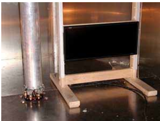
Abbildung 7-3: Modul montiert neben Ableit-Rohr
