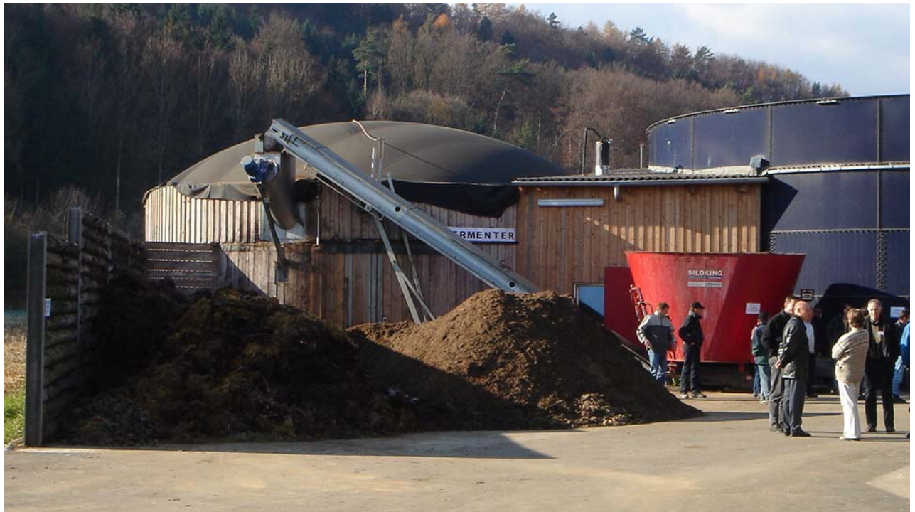
Fig. 11: In der Mitte ist der Fermenter mit der schwarzen Gasfolienhaube sichtbar. Vor dem Fermenter lagern die hauptsächlichsten Co-Substrate Getreideabgang und Mist.
