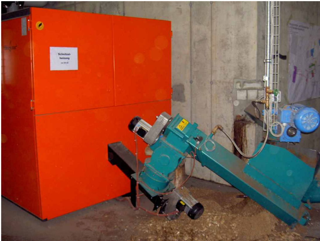
Fig. 13: 500 kW Holzschnitzelheizung
