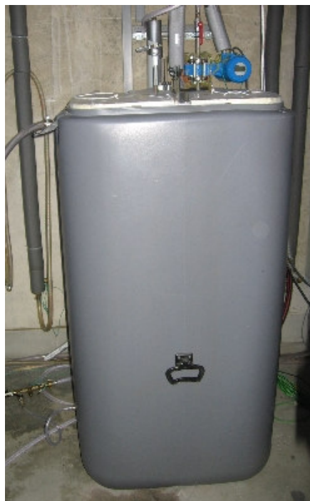
Figure 32 : Cuve grise en plastique et son système de mesures de températures.
