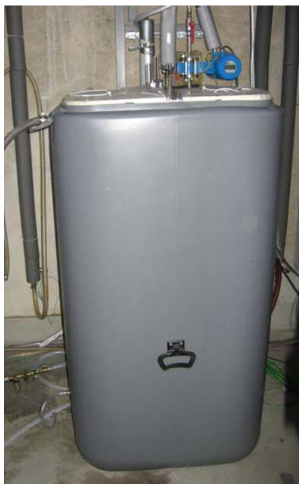
Figure 27 : Cuve grise en plastique et son système de mesures de températures.
