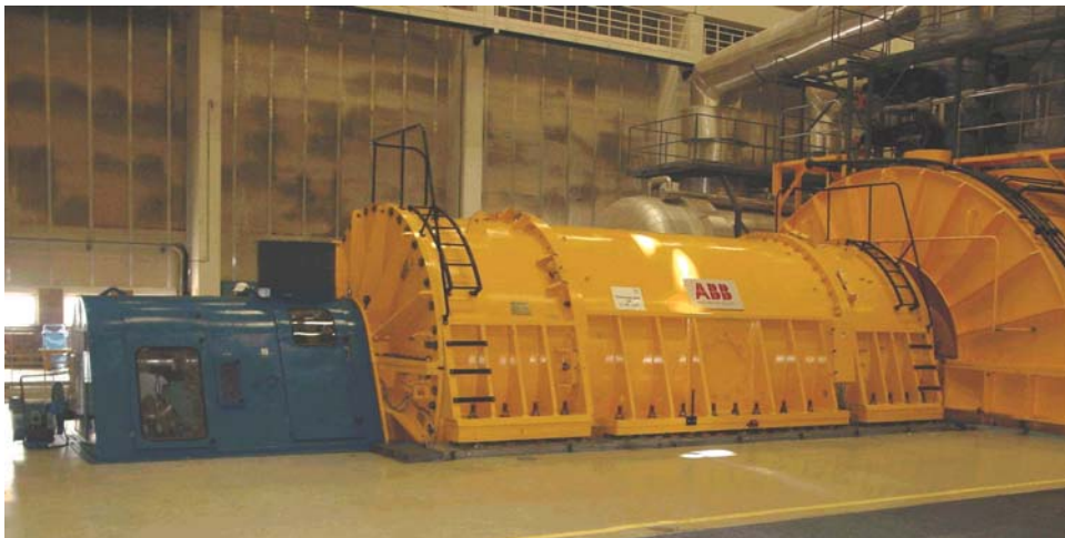
Fig. 10: Generator mit vollständig wassergekühlten Wicklungen (ALSTOM)
