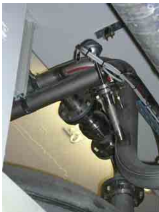
Druckaufnehmer und Drucktaupunkt-messung in Kompressorstation 934 (Champion)
