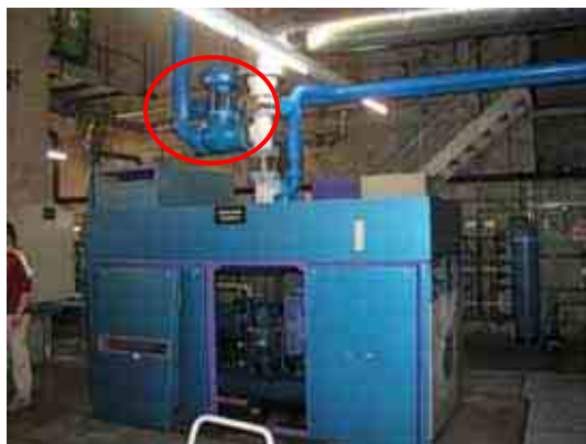
Aerzener Verdichter mit VSD für Fabrikluft. Einziger Verdichter, der das Netz vollständig versorgt. Bei Bedarf überströmen aus Steuerluftnetz. Oberhalb des Verdichters Steuerventil für die Abblaseleitung.
