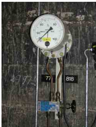
Volumenstrommessung mit Samson Z3 für einzelnen Betriebsteile
