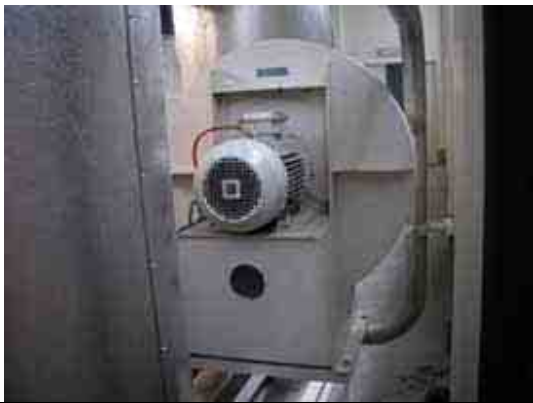
Gebläse des Delair Adsorptionstrockners. Antriebsmotor ABB, 5,5 kW
