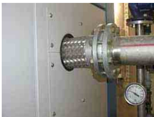
Flexible Kompressoranbindung über Schlauch
