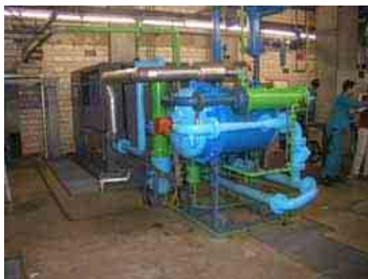
ZR4 Kompressor mit MD Trockner
