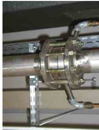
Eingebaute Staudrucksonde in Kompressorstation 934 (Champion)
