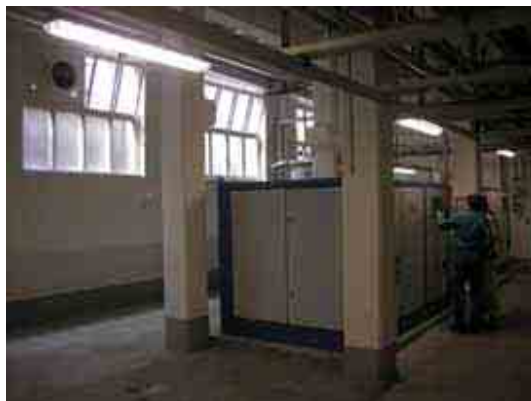
Zuluft für wassergekühlte Champion Kolbenkompressoren (Geb. 934) über gekippte Fenster. Hinweis: Spürbar erhöhte Raumtemperatur im Kompressorraum
