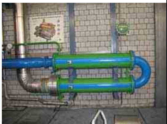
Druckluftkühler hinter Aerzener Kompressor mit Kühlwasser
