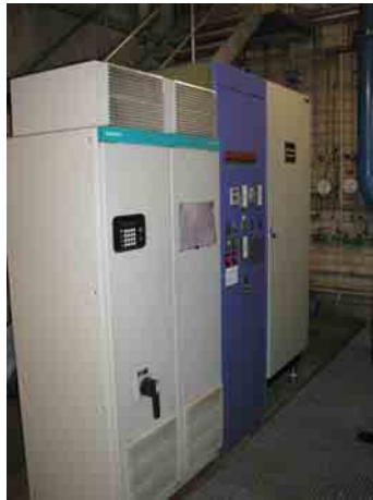
Steuerschrank mit VSD für Aerzener Kompressor für Fabrikluft
