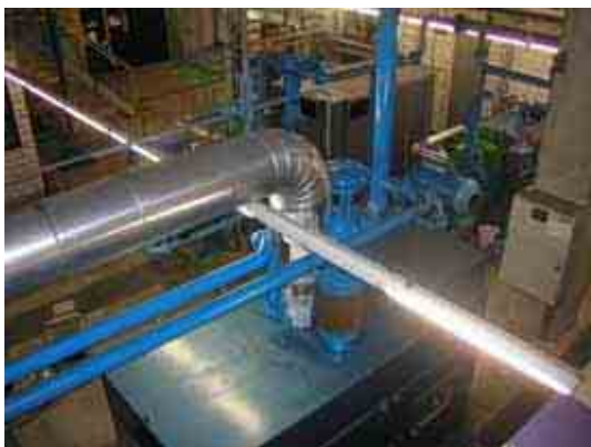
Blick auf den Fabrikluftverdichter (Vordergrund) und die Kompressoren ZR4 (links) und ZR3 (rechts)
