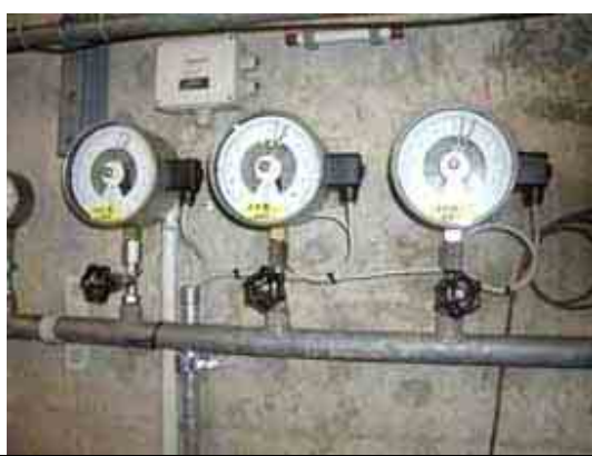
Einstellung der Druckschaltpunkte für die 3 ZR Maschinen im Steuerluftnetz
