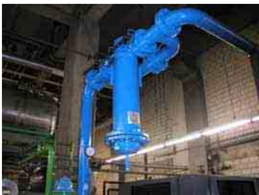
Druckluftfilter hinter Adsorptionstrockner des ZR4
