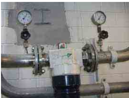
Filter mit Ein- und Austrittsmanometer hinter dem Adsorptionstrockner Delair
