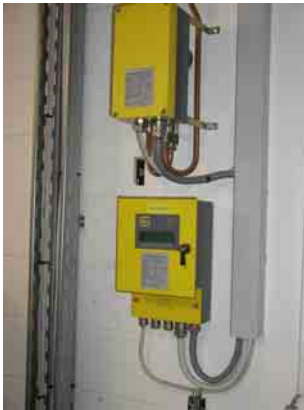
Auswerteeinheit für Volumenstrommessung in der Station mit Staudrucksonde (IWKA)
