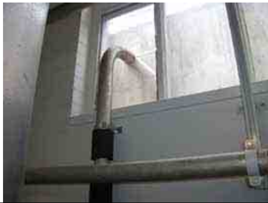
Abblaseleitung des Adsorptionstrockners delair nach außen
