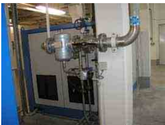
Zyklonabscheider mit Ecodrain und Absperrventil am Kolbenkompressor (LS 4.1)
