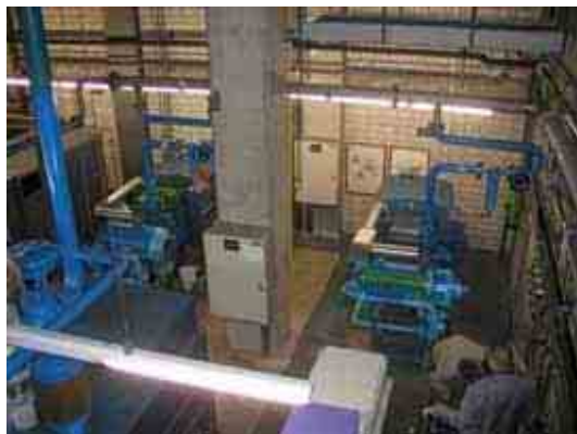
Kompressorstation 2 im Geb. 939. 2-mal ZR3 Kompressoren für Steuerluft und 1-mal Aerzener Schraube für Fabrikluft
