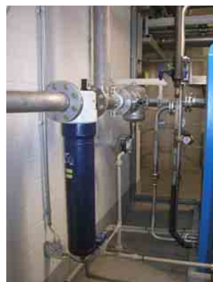
Filter vor Eintritt Adsorptionstrockner und externer Zyklonabscheider mit Ecodrain hinter Champion Kompressor
