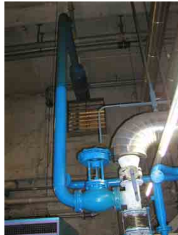
Abblaseleitung des Aerzener Kompressors (Fabrikluft) zur Jalousie
