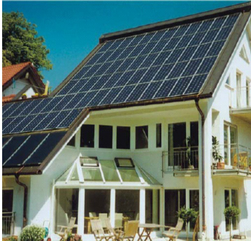
Fig. 7.5 PV-Dachanlage (Becker 2003).
