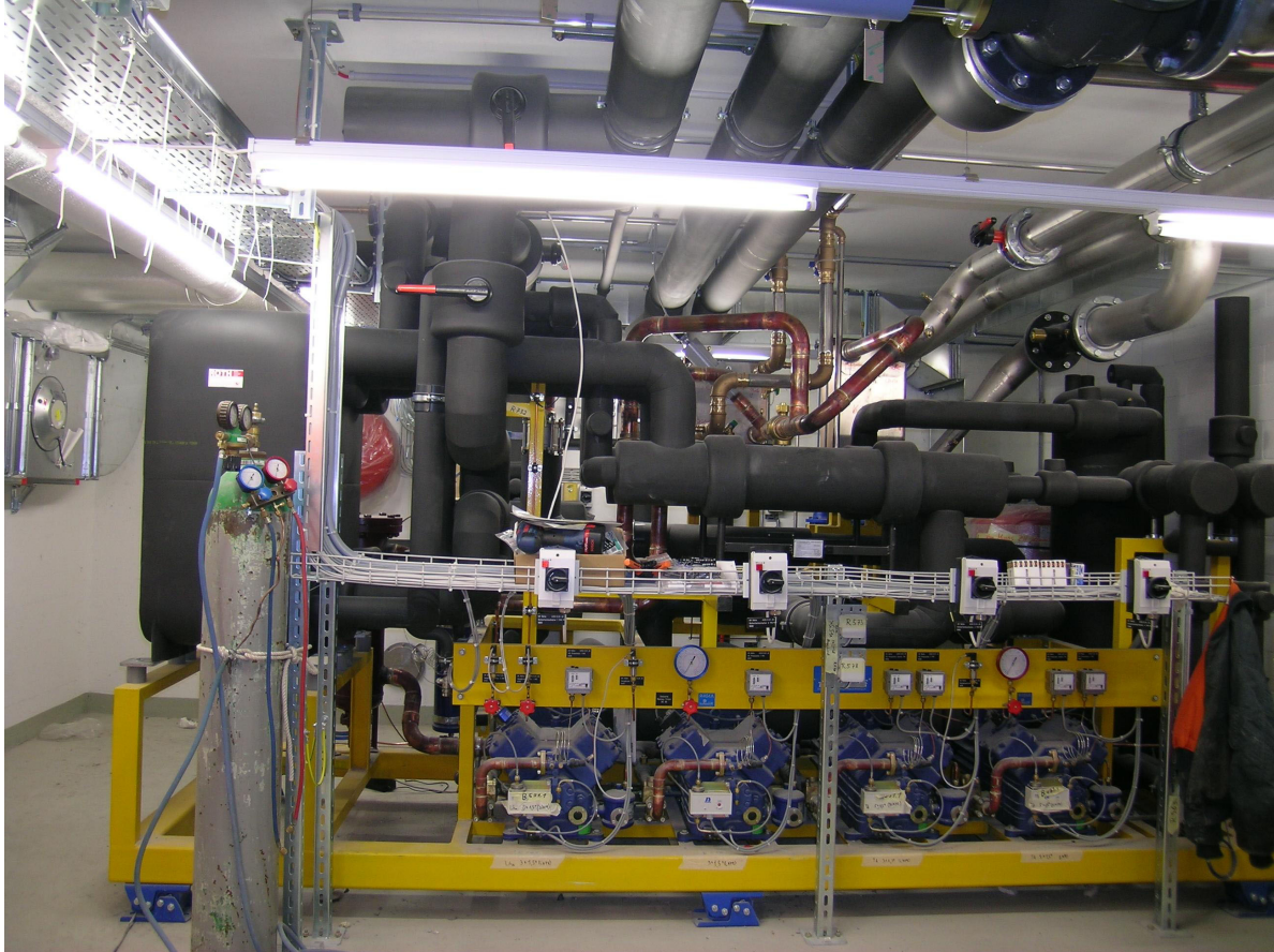
Kälteanlage der Firma Truttmann AG nach neustem Stand der Technik mit herkömmlicher Verdampfung.
