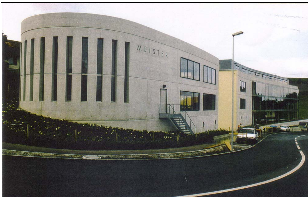
Fig. 1 : Bâtiment industriel Meister + Co AG à Wollerau (source Kapp und Morath, 1999).
