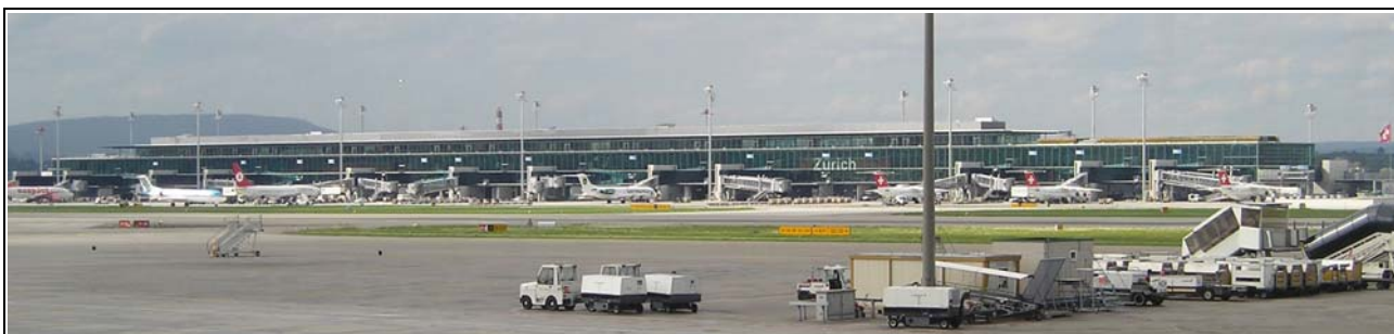
Fig. 1 : Dock Midfield de l'aéroport de Zürich.
