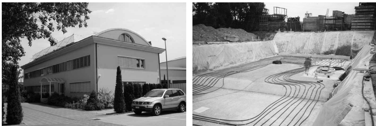
Fig. 1 : Bâtiment « Perret » et pose de l'échangeur eau/sol.
