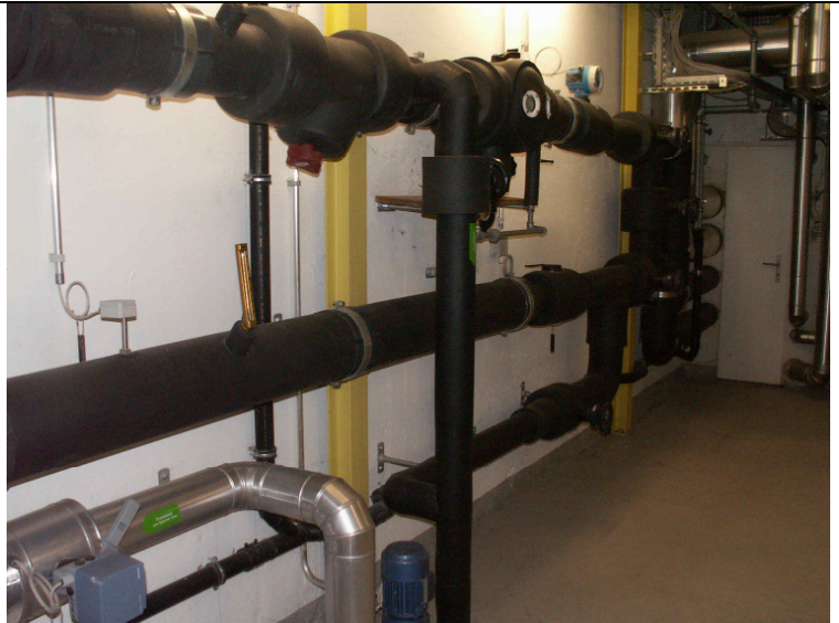
Abb. 6: Grundwasser als Wärmequelle, Länge und Dimension der Zuleitungen, bedarfsabhängige Förderung bei Teillastbetrieb ist nur mit mehreren Förderpumpen möglich
