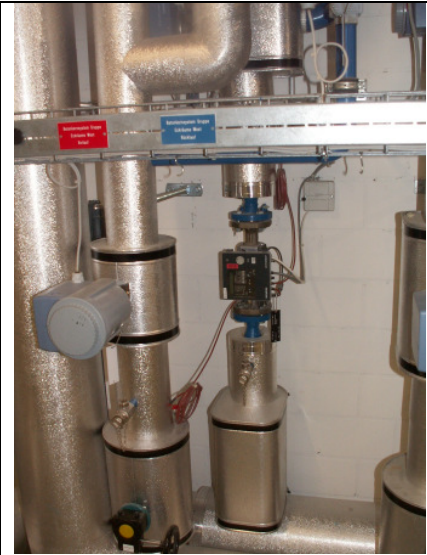
Abb. 4: Messeinrichtungen, Auslegung und Dimensionierung, Beachtung Druckverlust
