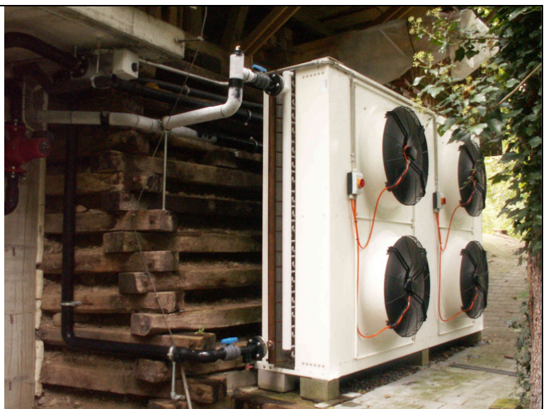
Abb. 2: Verdampfer mit Aussenluft als Wärmequelle, Aufstellungsort und Dimensionierung der Tauscherfläche, sowie die Länge der Kälteleitungen
