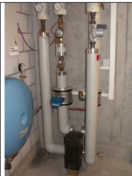
Abb. 1: Systemtrennung mit je einem Wärmetauscher pro Haus
