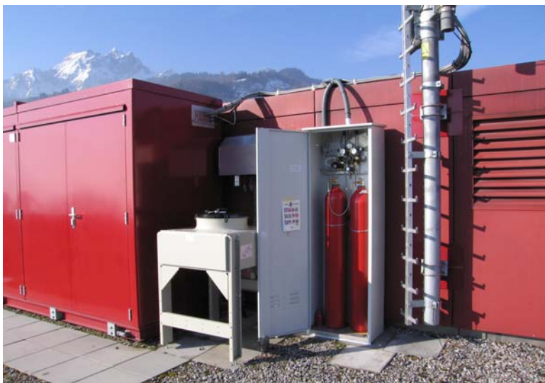
Fig. 9: Wasserstoffspeicher und Rückkühler
