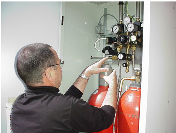
Fig. 6: Wasserstoff-Umschaltstation
