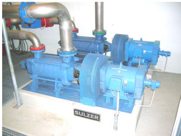
Fig.25 – Pumpturbinen der WV Altstätten
