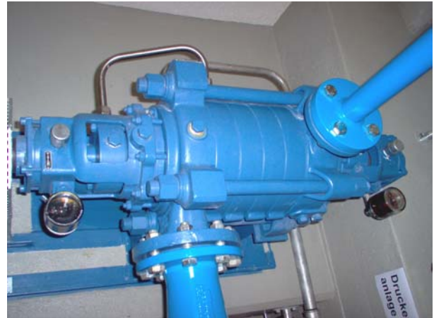
Fig.4 - Rückwärtslaufende Pumpturbine (RLPT)
