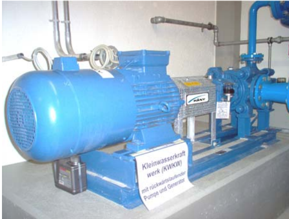
Fig.3 - Rückwärtslaufende Pumpturbine mit direkt gekoppeltem Asynchrongenerator
