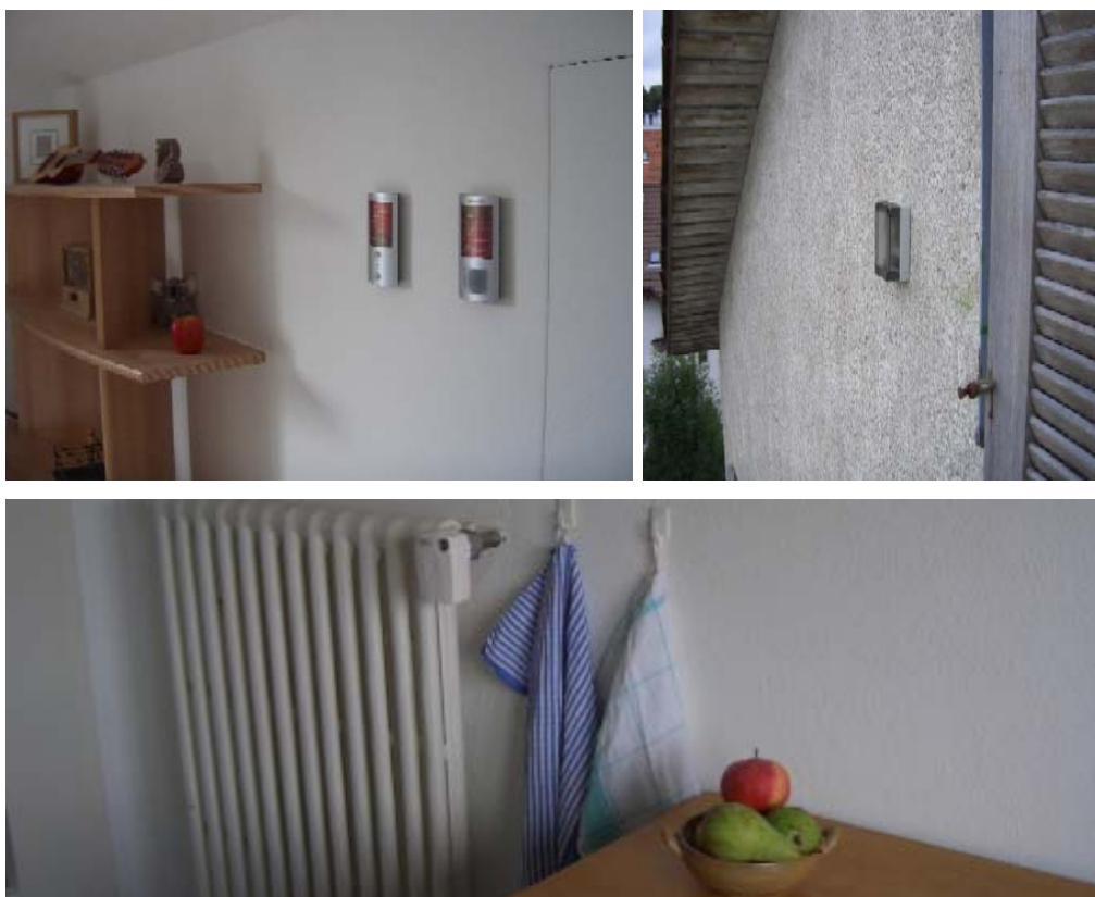
Figure 6 : Appartement type B avec les composants installés
