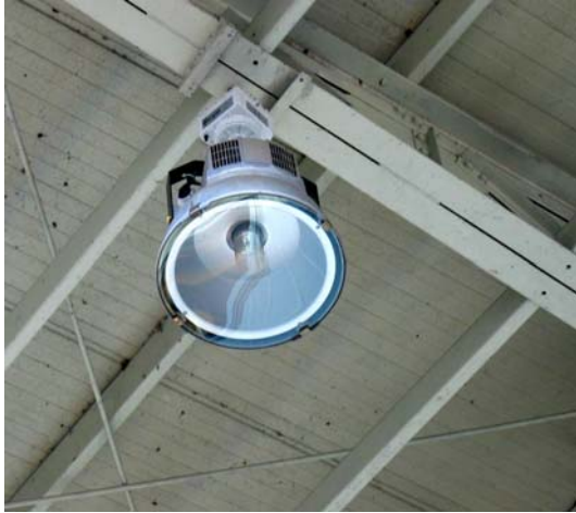
Figure 2 PLS en plafonnier (puissance nominale : 700 W, efficacité lumineuse : 80 lm/W)
