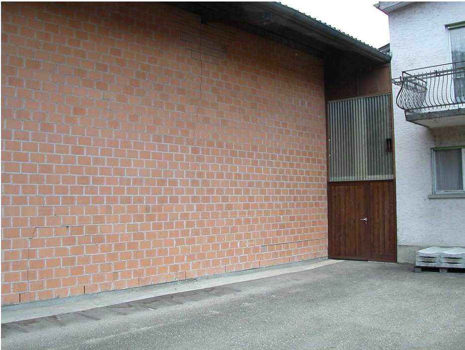
Bild 16 Hintere Trocknungskammerwand, ein Teil ist in der Halle und ein Teil an der frischen Luft
