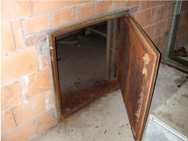
Bild 11 Abluftsammelkanal
