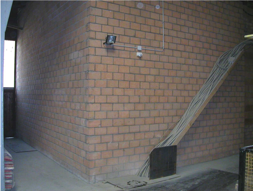
Bild 18 Hintere Trocknungskammerwand und linke Seitenwand in der Halle
