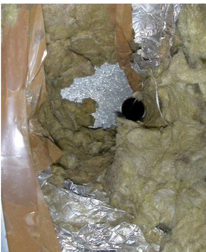
Bild 15 Bohrung zur Messung der Abluft
