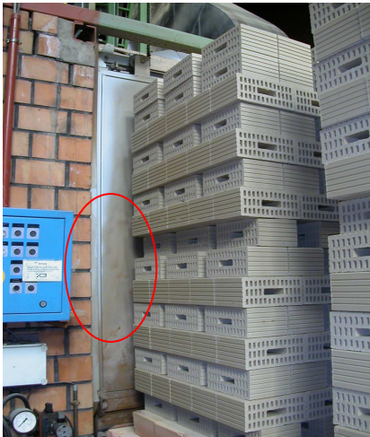
Bild 25 Eingang zum Tunnelofen
