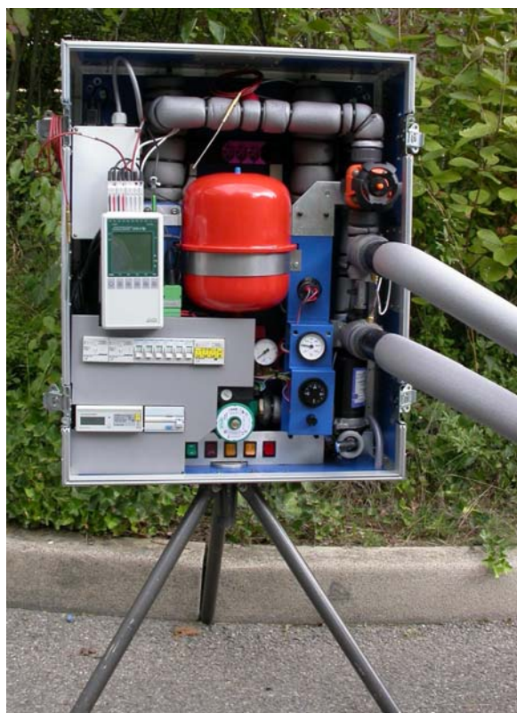
Figure 5: Aperçu global des modifications. On remarque la nouvelle position du module de télétransmission avec une nouvelle antenne
