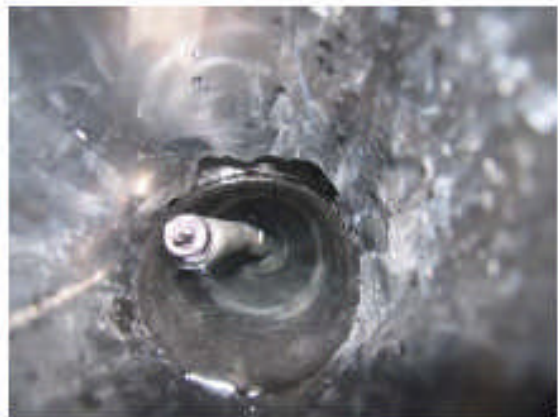
Figur 8: Ausgespülte Messsonde in der Fangvorrichtung
