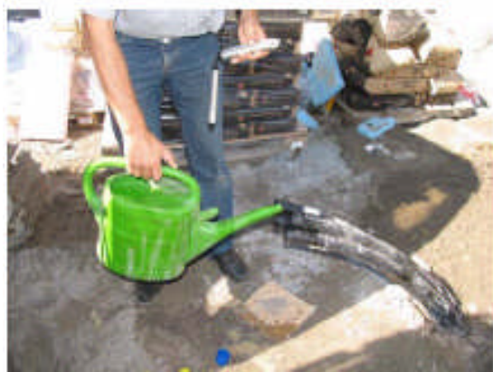
Figur 6: Auffüllen der EWS Rohre mit Wasser
