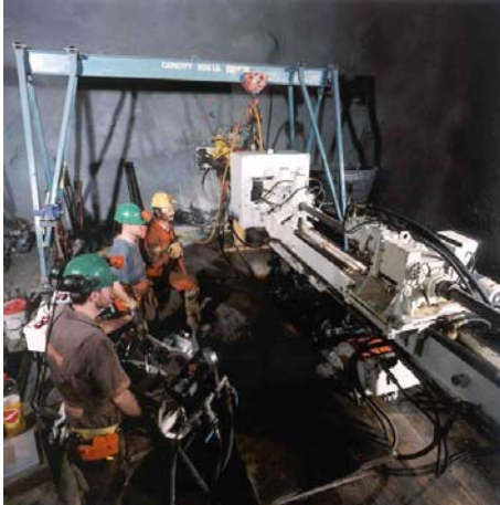
Fig.3.4 Installation de forage de reconnaissance et de drainage dans l'axe d'un tunnel (ATL)
