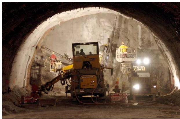
Fig. 4.5 Jumbo de perforation à bras multiple (ATG)
