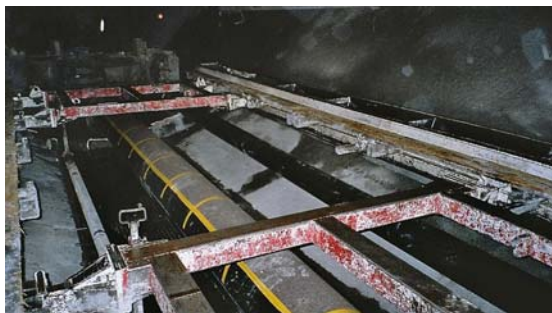
Fig. 4.7 Système de collecteur d'eau en cours de pose dans un tunnel
