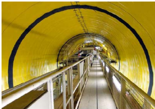
Fig. 3.7 Membrane d'étanchéité avant bétonnage de l'anneau intérieur
