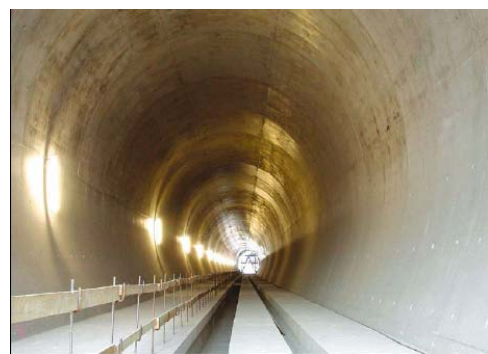
Fig. 3.8 Anneau intérieur en béton et radier du tunnel terminés
