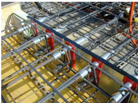
Abb. 1: Eingebaute Prototypen von Thermotragelementen
