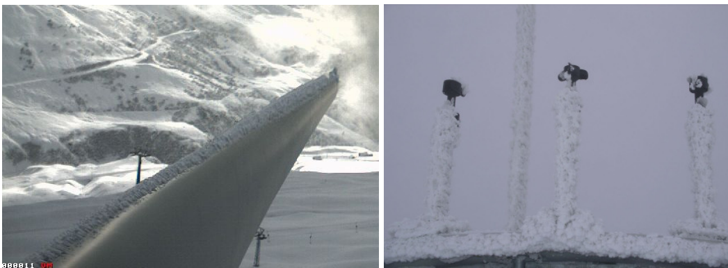
Abb. 10: Typischer Eisansatz auf dem Rotorblatt einer WKA (links, Gütsch) und an den Windmessgeräten auf der Gondel einer WKA (rechts, Feldmoos, Entlebuch).
