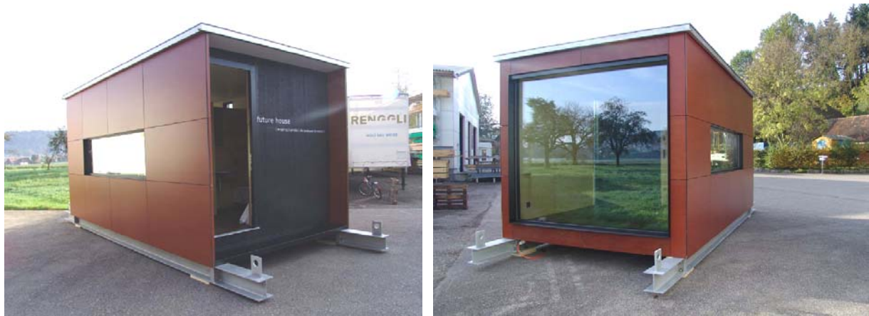
Abbildung 2: Der als Kleinstwohnung (BGF 18 \text{ m}^2 ) mit Minergie-P Standard konzipierte Pavillon mit Vakuum-Dämmung aller opaker Bauteile.
