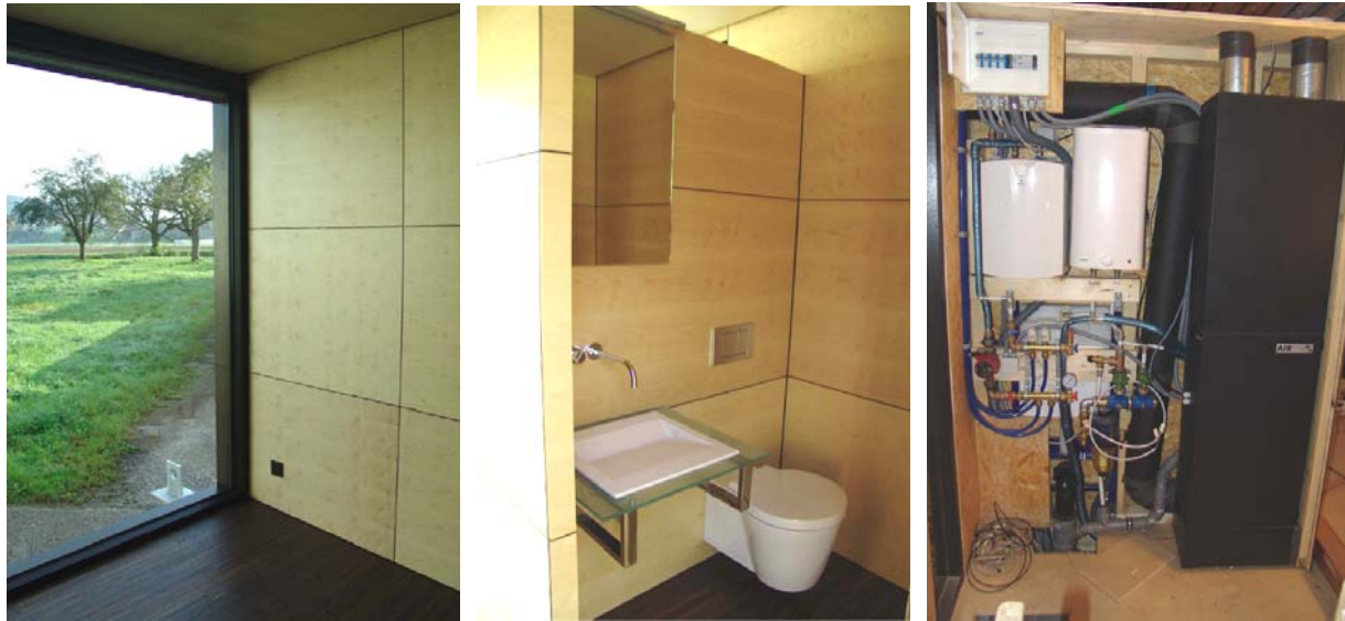
Abbildung 8: Der als Kleinstwohnung (BGF 18 m 2 ) mit Minergie-P Standard konzipierte Pavillon mit Vakuum-Dämmung aller opaker Bauteile.
