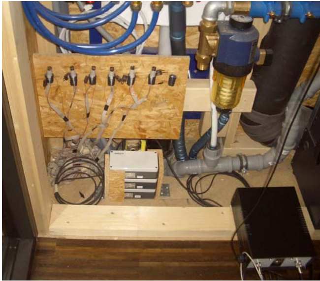
Abbildung 14: In der Haustechnik-Box wurden alle Kabel von Innendruck- und T/RH-Fühlern zusammengeführt..
