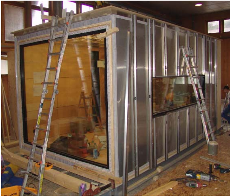
Abbildung 9: Der Pavillon in der Bauphase. Gut sichtbar die Sandwichpaneele und die Alu-Klemmleiste, mit welcher im nächsten Schritt die Prodema-Fassadenpaneele verklebt werden.
