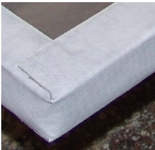
Abbildung 11: Klebeband, welches den stirnseitigen Abschluss der Qasa-Elemente bildet.
