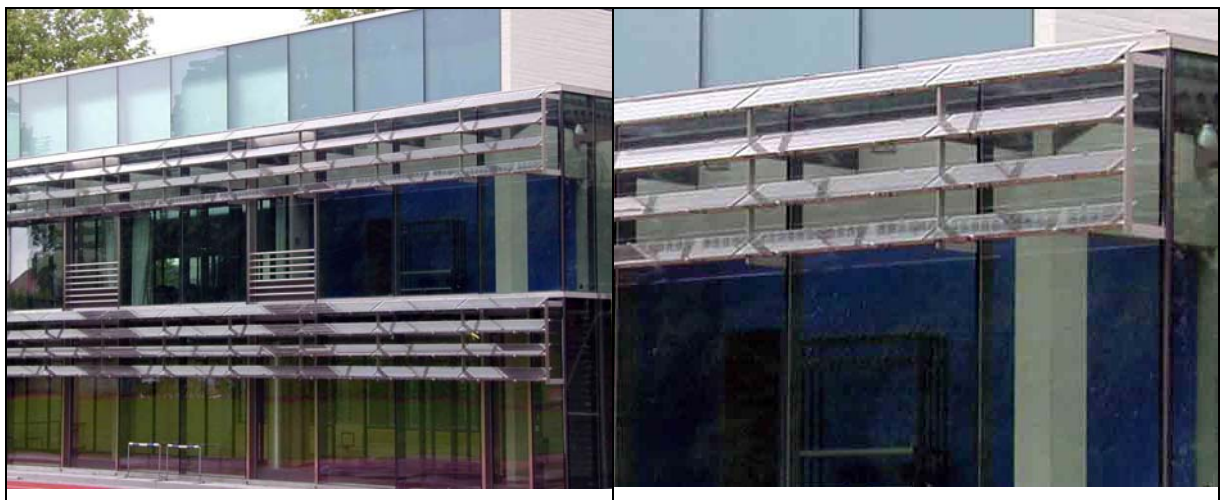
Figur 2-18 Beispiel aktiver Sonnenschutz
