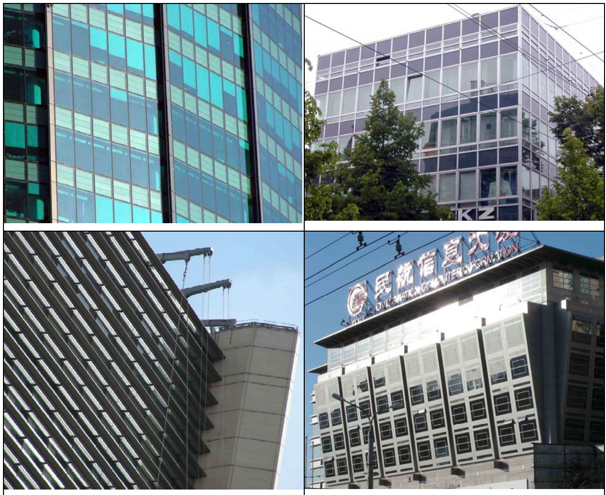
Figur 2-19 Pseudo-Glasfassade, geneigte Fassaden
