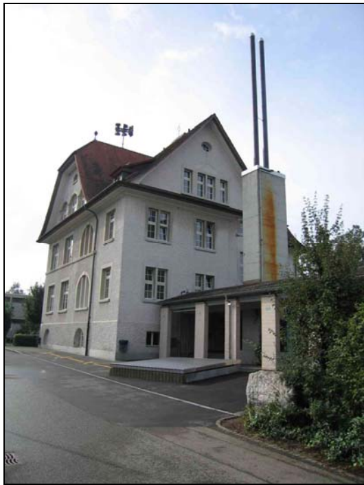
Abbildung 3: Kamine und Silodeckel
