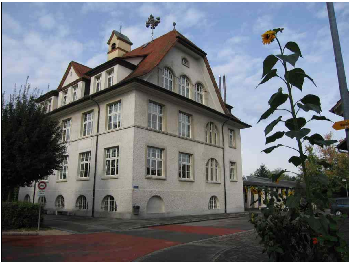
Abbildung 2: In diesem Schulhaus befindet sich die Heizzentrale, die beiden Kamine sind hinter dem Gebäude sichtbar
