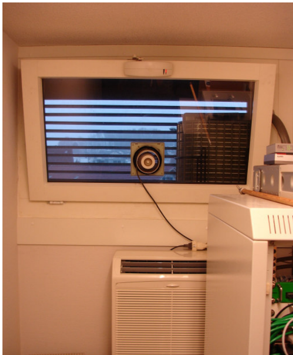
Bild 3-1 Lüftungsanlage, Fensteröffner und Raumklimagerät
