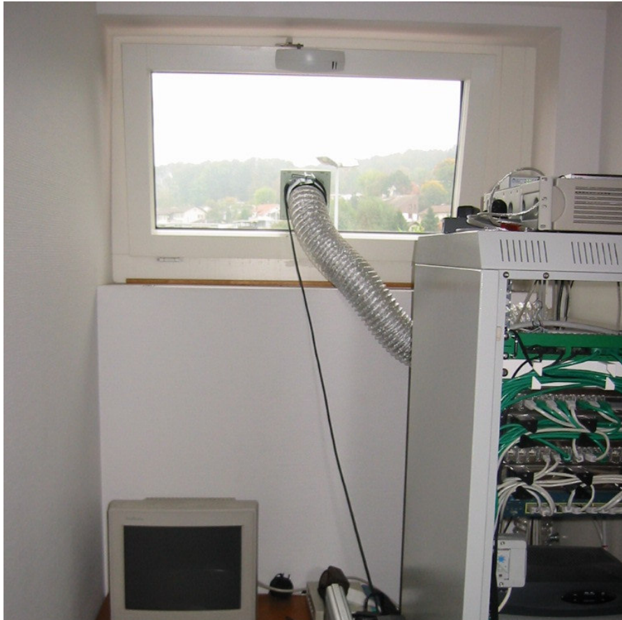
Bild 2-1 Lüftungsanlage und automatischer Fensteröffner
