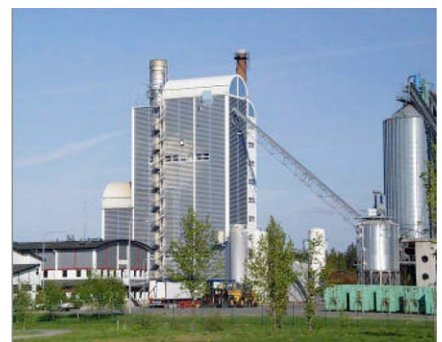
Bild 2.1 Prinzip eines Holzgas-Kombikraftwerks (IGCC, Integrated Gasification Combined Cycle). Der Aufbau zeigt eine Anlage mit Druckvergasung in einer zirkulierenden Wirbelschicht der Demonstrationsanlage in Värnamo (Schweden) mit folgenden Betriebsdaten: Vergasungsdruck: 20 bis 25 bar, elektrische Leistung 6 MWe, davon Gasturbine 4 MWe und Dampfturbine 2 MWe, Fernwärmeauskopplung maximal 9 MW, elektrischer Wirkungsgrad 32% bis 37%. Quellen: [Hofbauer & Kaltschmitt 2001, Stahl & Nehrgard 1996 und 1998, Stahl et al. 2004].
