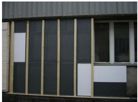
Fig. 5: Ansicht der Testmontage des Distanzschrauben-Systems, vor der Montage der Aussenschale.
