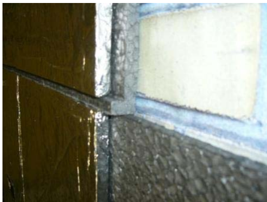
Fig. 4: Detailansicht der EPS-Fuge für die Distanzschraube im Arbeitsmodell (Masstab 1:2).
