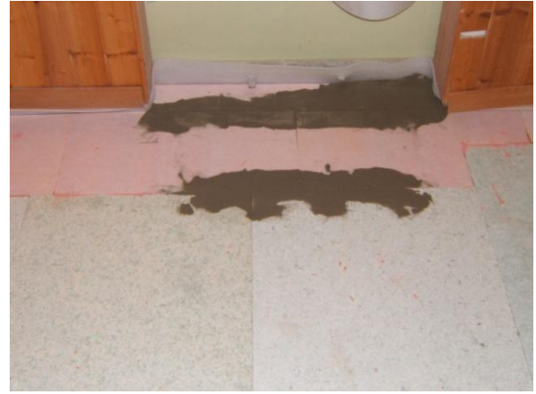
Bild 4: Testraum für Feldmessungen: Auffüllung von Restflächen mit alternativem Dämmmaterial.
