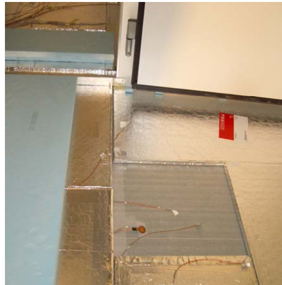
Abbildung 13: Vertikalschnitt durch den Boden-/Wandanschlussbereich des Tiefkühlraums (links), Verlegung der VIP und Anbringen der Sensoren (rechts).
