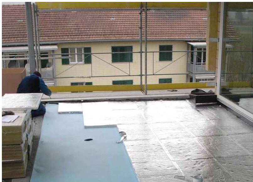
Abbildung 1: Dämmung einer Terrasse mit VIP. Als Schutzschichten werden beidseitig dünne konventionelle Dämmplatten oder Bautenschutzmatte eingesetzt.
