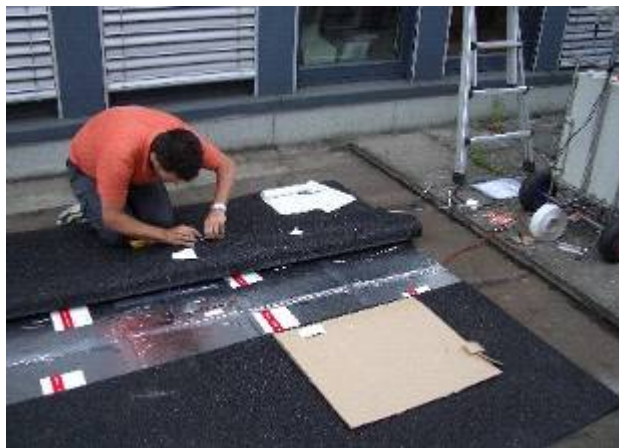
Fig. 8: Bilder vom Einbau der zwei VIP-Testfelder.
