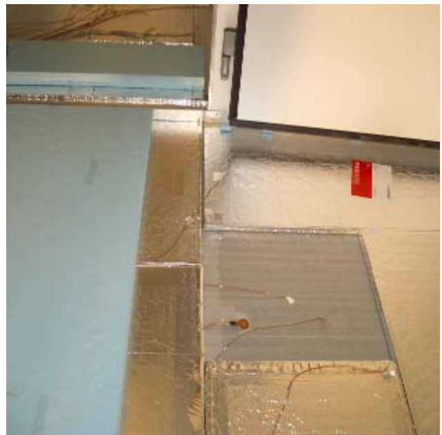
Fig. 3: Vertikalschnitt durch den Boden-/Wandanschlussbereich des Tiefkühlraums (links), Verlegung der VIP und Anbringen der Sensoren (rechts).
