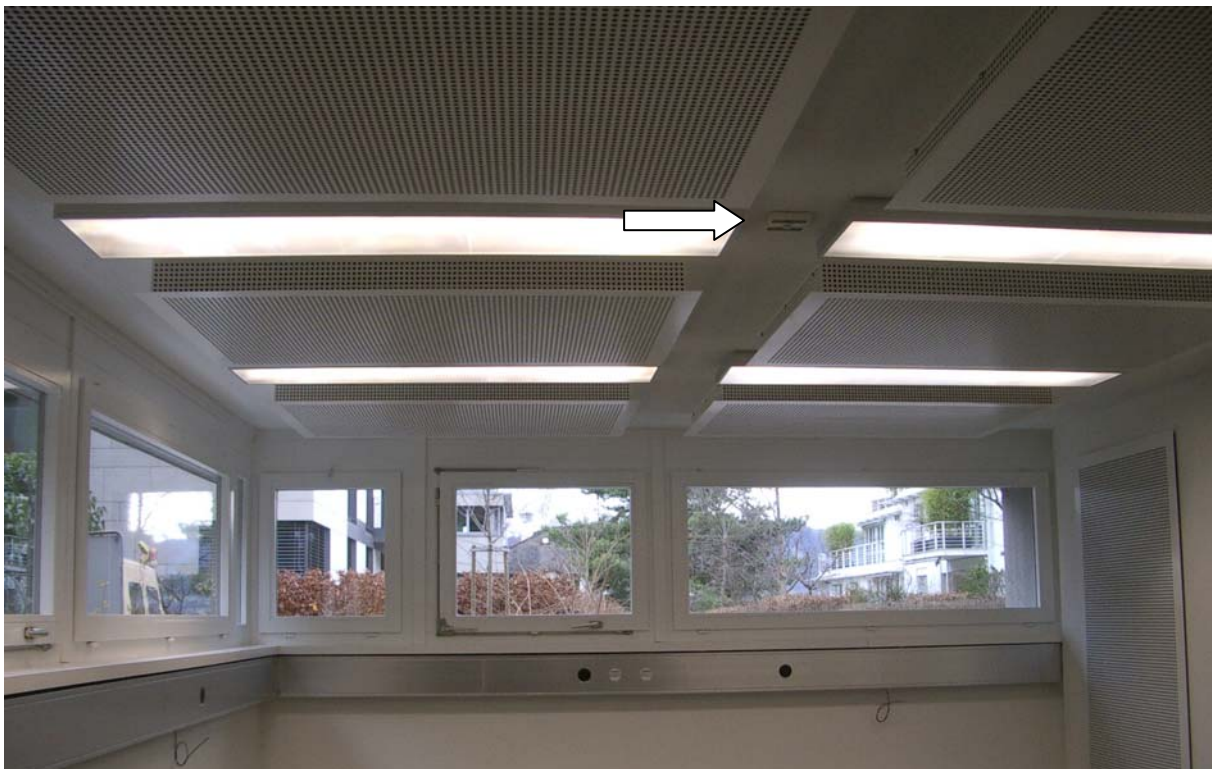
Fig. 5 Pilotanlage Attenhoferstrasse 8 mit SENSOLUX (Prototyp, Pfeil) ausgerüsteter Raum. Einfache Montage des Präsenzmelders durch Anschrauben oder ankleben einer Grundplatte an der Decke. Der PIR wird über einen Bajonettverschluss an der an der Grundplatte befestigt.
