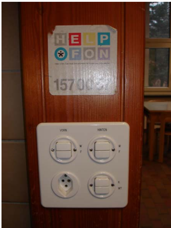
Bild 2 Schaltstelle in einem Klassenzimmer in Thalwil, zu viele Schaltgruppen sind eher verwirrend, der Akteur könnte an der frei werdenden Stelle eines Schalters installiert werden
