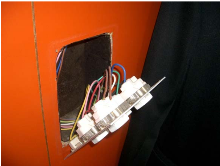
Bild 1 Schaltstelle in einem Klassenzimmer, Sekundarschulhaus Sternmatt II in Baar der Schaltaktor muss im Hohlraum hinter der Schaltstelle untergebracht werden (evtl. aufbohren)
