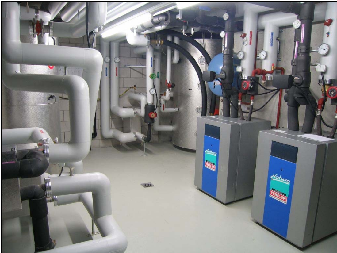
Abbildung 2: Heizzentrale; links der Heizspeicher, hinten der Warmwasserspeicher von CIPAG, rechts die beiden Wärmepumpen von SATAG
