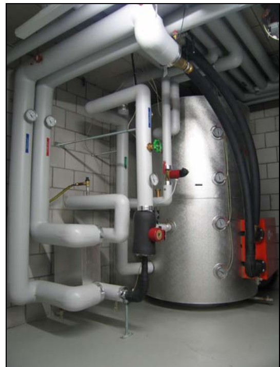
Abbildung 4: Warmwasserspeicher; links der ausenliegende und rechts der provisorisch angeschlossene innenliegende Wärmetauscher
