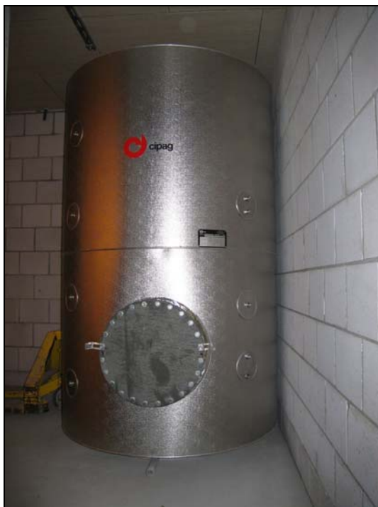
Abbildung 3: Warmwasserspeicher; der Mannlochdeckel gibt eine Ahnung von der Grösse des später montierten Wärmetauschers
