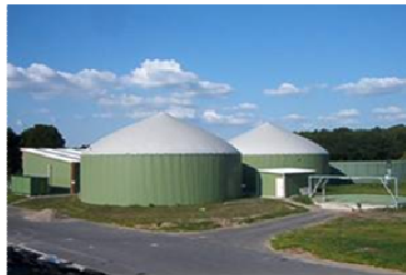
Abbildung 23 und 24: Biogas-Fermenter in Pirow gebaut nach dem Prinzip des Loock-TNS®-Verfahrens. Ansicht der Feststoffvergärung (links) und der Flüssigvergärung (rechts – Quelle 23 ).
