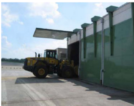
Abbildung 19: Garagen-Verfahren der Firma Bekon Energy Technologies GmbH & Co. KG bei Fröttmanning (Stadt München, Quelle 20 ).
