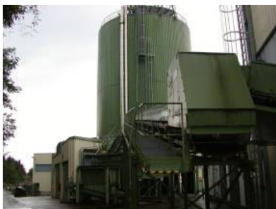
Abbildung 6: Anlage mit typischem Dranco-Fermenter: Ein stehender, schlanker Gärreaktor (Quelle 7 ).
