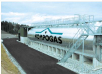
Abbildung 3: Kompogas-Anlage mit typischem Design: ein liegender schlanker Pfropfenstrom-Fermenter (Quelle Kompogas AG).
