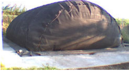
Abbildung 30: Fahrsilo-Fermenter mit Folienhaube (gefüllt mit Biogas).
