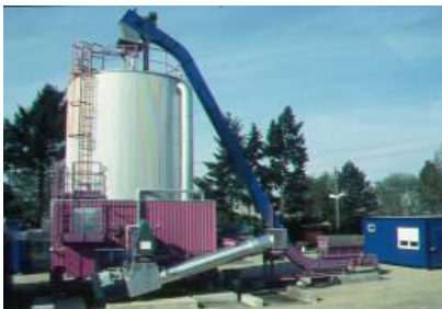
Abbildung 8: Pilotanlage in Hamburg-Bergedorf mit einem Reaktorvolumen von 100m 3 (Quelle 9 ).
