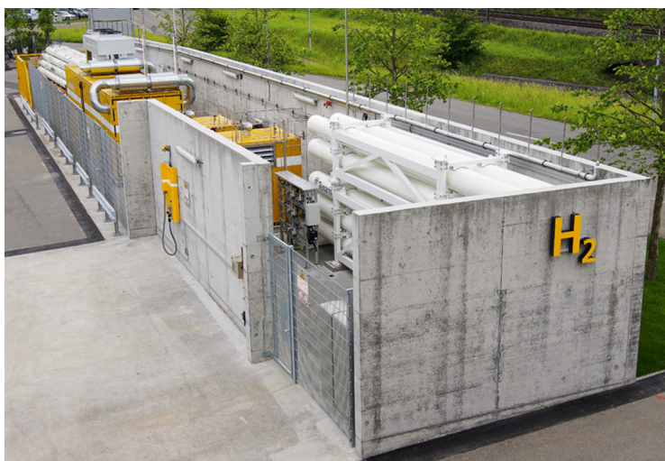
Figur 4: (Links) Erste Schweizer Wasserstofftankstelle in Brugg AG, welche im Mai 2012 eröffnet wurde. Ein Teil des Wasserstoffs wird vor Ort durch Elektrolyse produziert (Produktionskapazität von 1'440 Nm 3 /Tag), der andere Teil wird per Trailer angeliefert. Wasserstoff wird bei 450 bar gespeichert mit einer Speicherkapazität von 5'000 Nm 3 . Die Busse werden mit Wasserstoff von 350 bar betankt. (Rechts) Im Zusammenhang mit dem vorhergesehenen Einsatz der Wasserstoffbusse von PostAuto am WEF 2013 wurden im Sommer 2012 Versuche in Davos durchgeführt, um die Leistung des Brennstoffzellenantriebs bei veringertem Sauerstoffpartialdruck zu testen.
