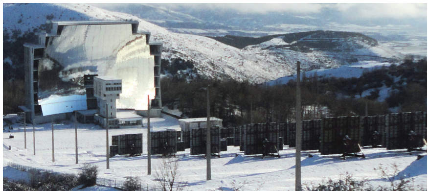
Figur 5: Konzentrierende Solaranlage des CNRS-Labors in Odeillo, Frankreich (1-MW-Solar furnace).
