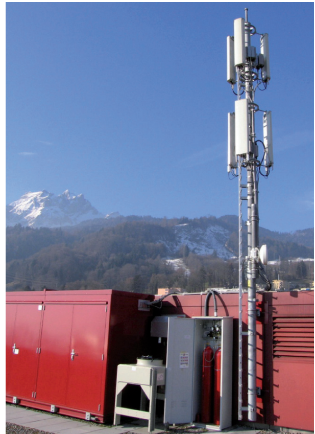
Figur 6: (Links oben) Die in der USV-Anlage eingesetzte 10 kW-Polymer-Elektrolyt-Membran-Brennstoffzelle. (Links unten) Blockschaltbild der Anlage. (Rechts) Mobilfunk-Basisstation (GSM/UMTS) auf dem Dach der Hochschule Luzern (Quelle: HTA Luzern).
