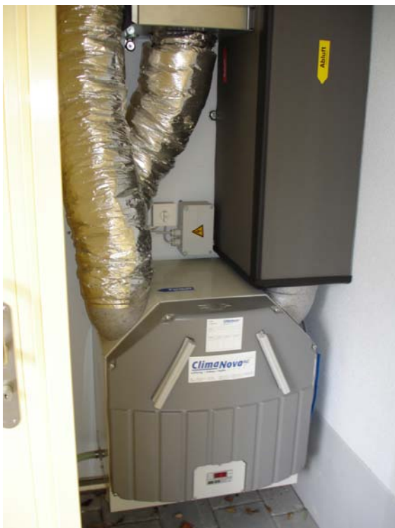
Abbildung 7: Das Zehnder Comfoair G90-300 von Storkair im Objekt Baar.
