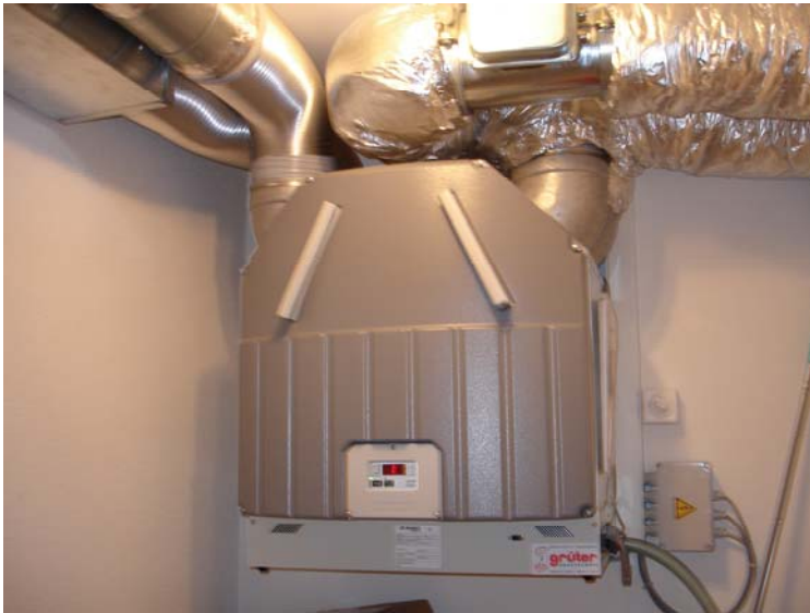
Abbildung 6: Das Zehnder Comfoair G90-300 von Storkair im Objekt Engelberg
