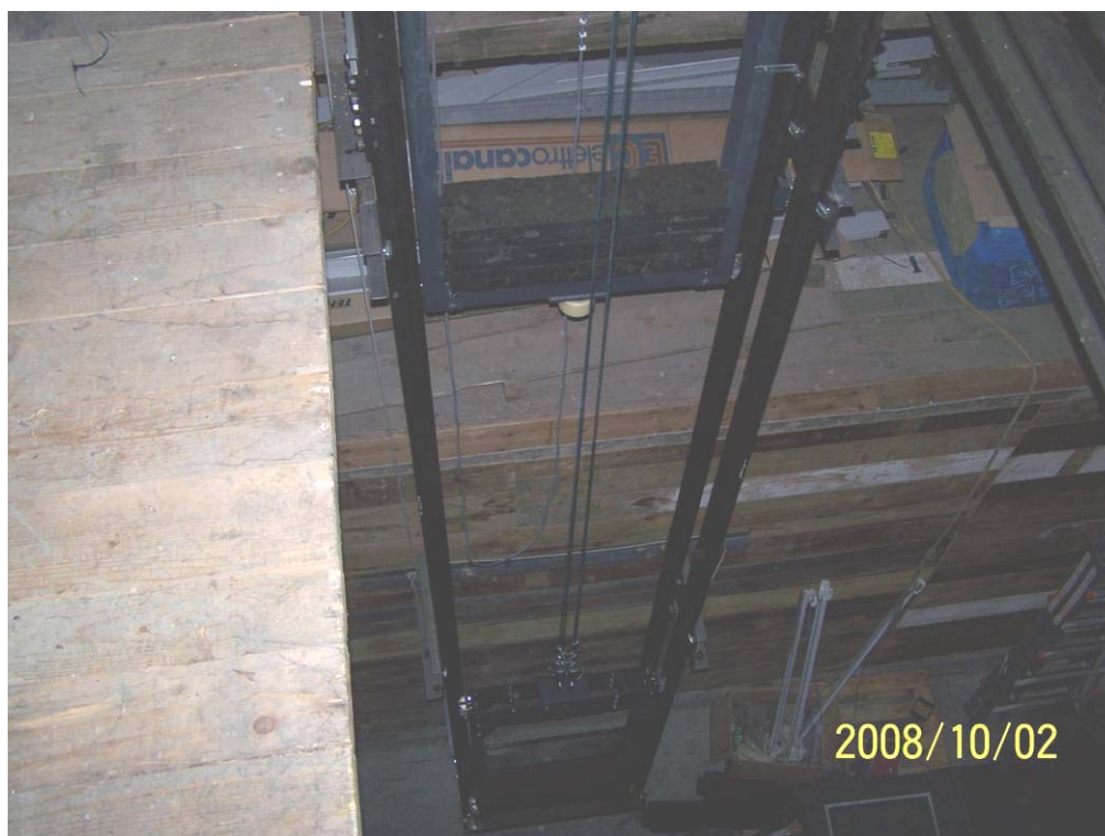
Bild 2: Liftschacht mit Gewichten
