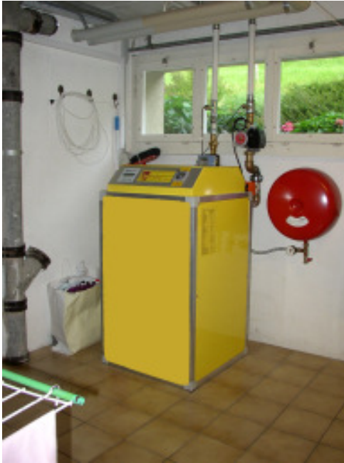
Abb. 9: Ansicht des innen aufgestellten Wärmepumpenteils der Heizanlage A
