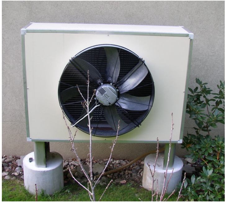
Abb. 10: Ausseneinheit mit drehzahlgesteuertem Ventilator der Heizanlage A. Der Ventilator verursacht nur wenig Lärm.
