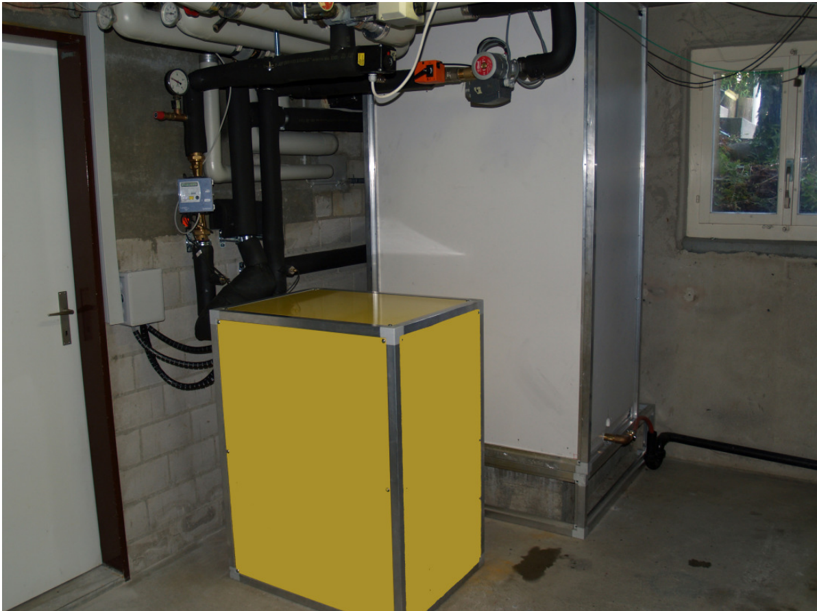
Abb. 13: Anlage B mit Aussenluft-Wärmetauscher im Hintergrund (hellgrauer Kubus)
