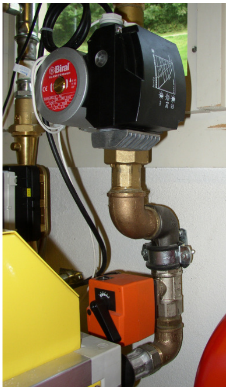
Abb. 11: Baugruppe „Ladekreissteuerung“. Drehzahlvariierte UP und gesteuertes Drosselventil (orange)
