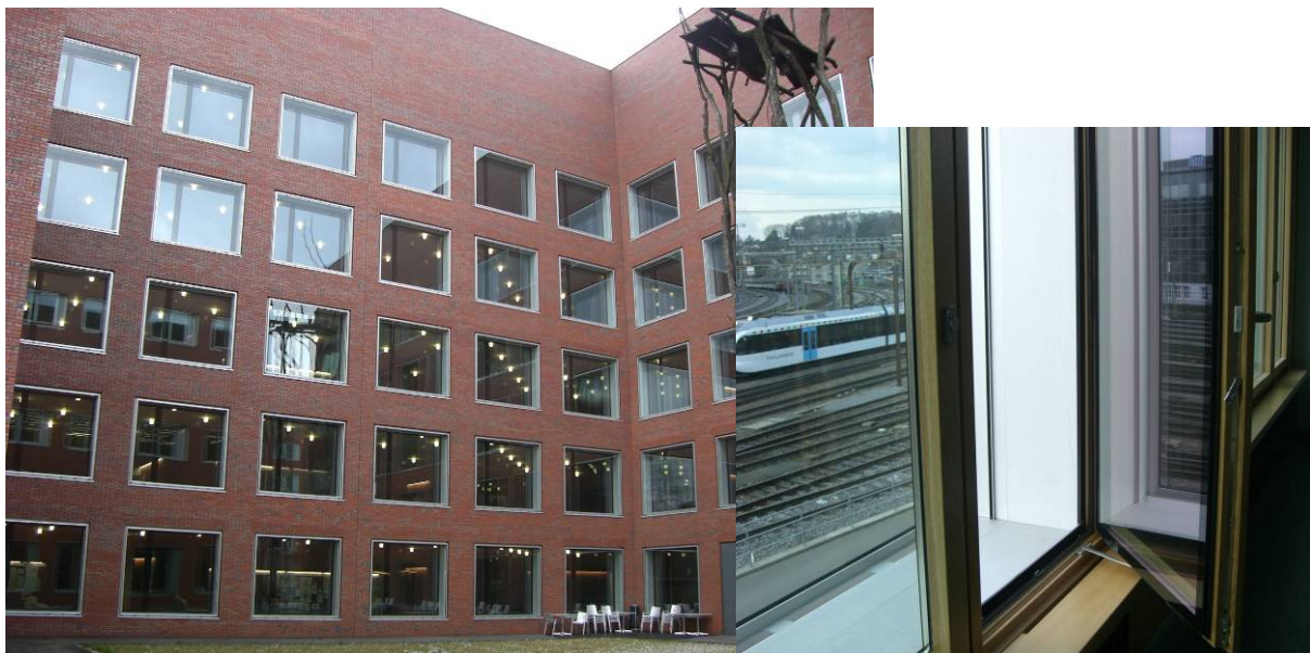
Abbildung 5.2 Mäander: Ansicht von der Hofseite; kleines Bild: Fensterflügel öffnet nur gegen eine zweite Glasschicht
