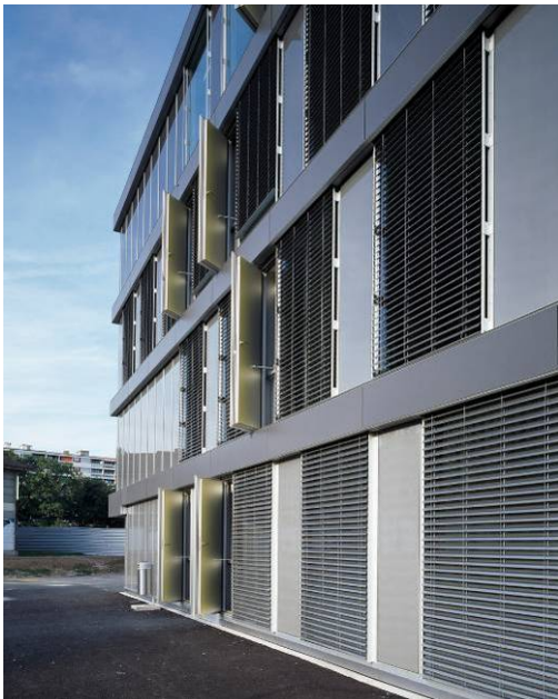
Abbildung 7.2 Ein Objekt mit ähnlichen Lüftungsflügeln, hingegen nach Aussen öffnend wurde kürzlich in Genf fertig gestellt (Cycle d'orientation Cayla, photo: Susanna Fritscher)
