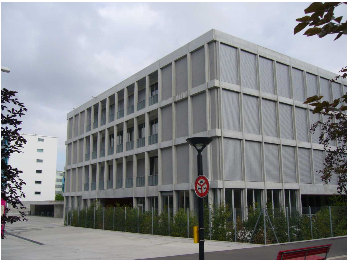
Abbildung 3.3 Aussenansicht Fassade, Schulhaus Birch Trakt A (Oberstufe), Süd- und Ostfassade
