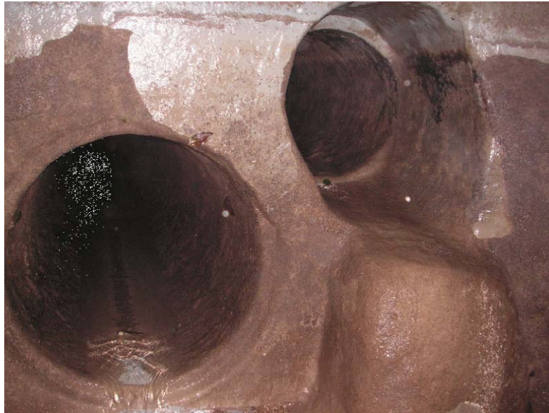
Photo 4. Conduites vues depuis la chambre d'eau
