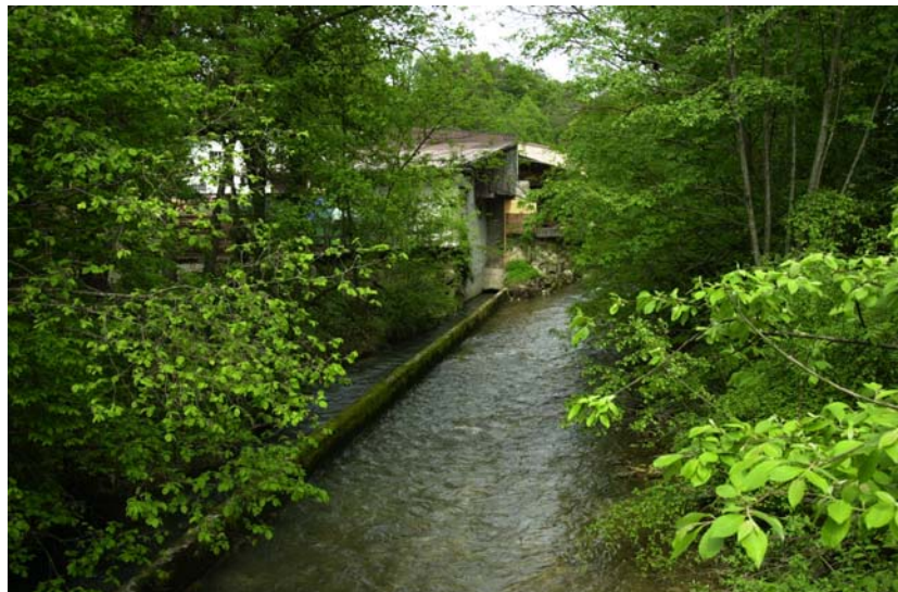
Photo 3. Vue de la scierie depuis l'aval avec la sortie du canal de fuite de la turbine Francis
