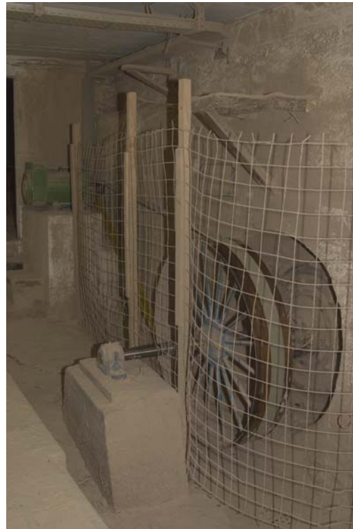
Photo 2. Turbogroupe: multiplicateur à courroie et alternateur
