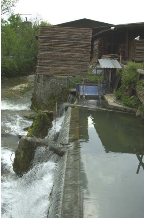
Photo 1. Canal d'amenée et seuil
