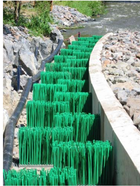
Photo 6. Exemples de passe à poissons à brosse (source: Université de Kassels, Allemagne)
