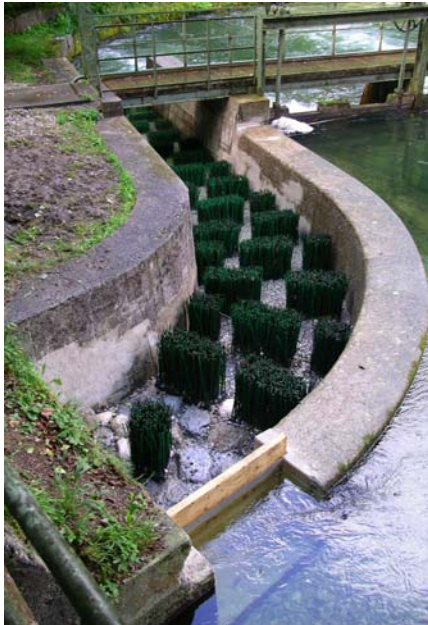
Photo 6. Exemples de passe à poissons à brosse (source: Université de Kassels, Allemagne)
