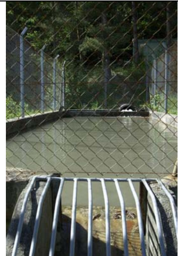
Photo 5. Trop plein du désableur où sont effectuées les mesures de débits
