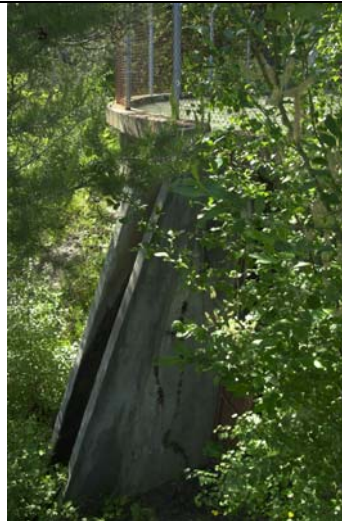
Photo 4. Trop plein du réservoir où sont effectuées les mesures de débits
