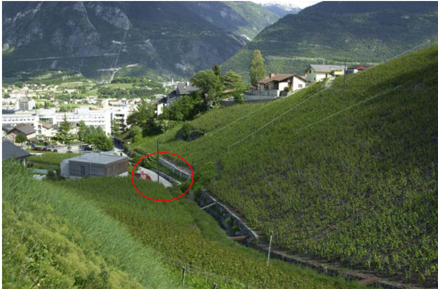
Photo 2. Emplacement de la future centrale de turbinage: à proximité de la Bonne Eau, de la ligne à haute tension et de la zone habitable de St-Ginier
