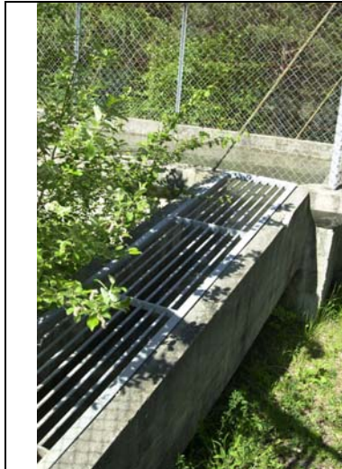
Photo 3. Canal de sortie du désableur où sont effectuées les mesures de débits
