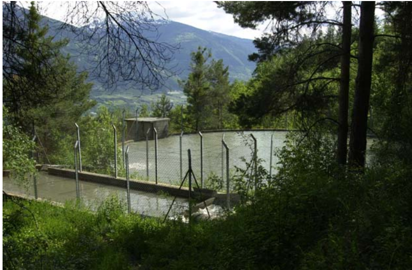
Photo 1. Réservoir du réseau d'irrigation de la commune de Venthône (et désableur)
