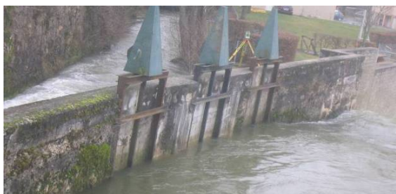
Vannes du canal des Fabriques
