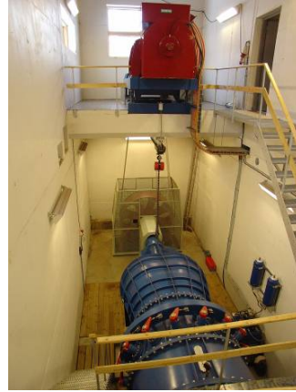
Transmission par courroie plate
