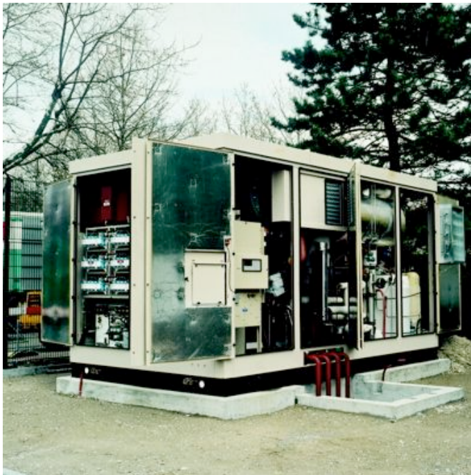
Abb. 6: Brennstoffzelle im geöffneten Zustand
