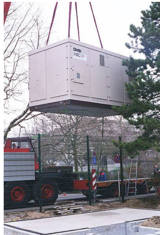
Abb. 2: Die BZ wird auf das vorbereitete Fundament gehievt
