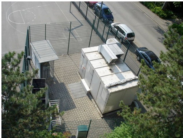
Abb. 3: Areal mit BZ, Kühler und Stickstofflager
