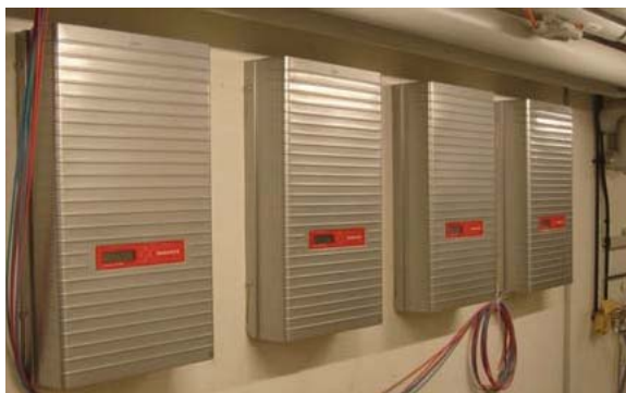
Abbildung 3: Wechselrichter
