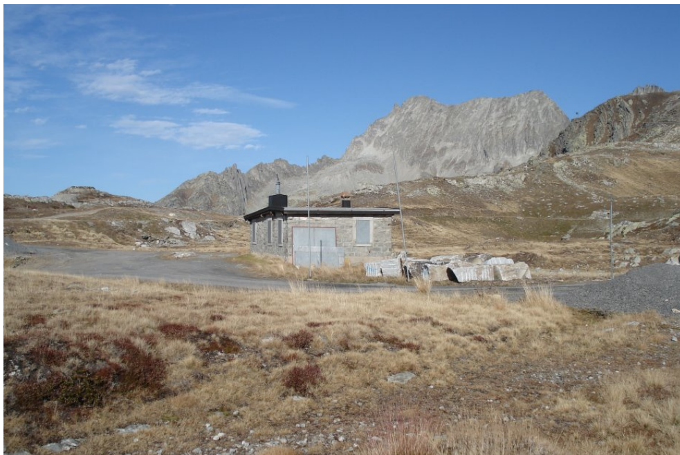
Abb. 9: In diesem Gebäude könnte eine Messzentrale für den TTS eingerichtet werden.
