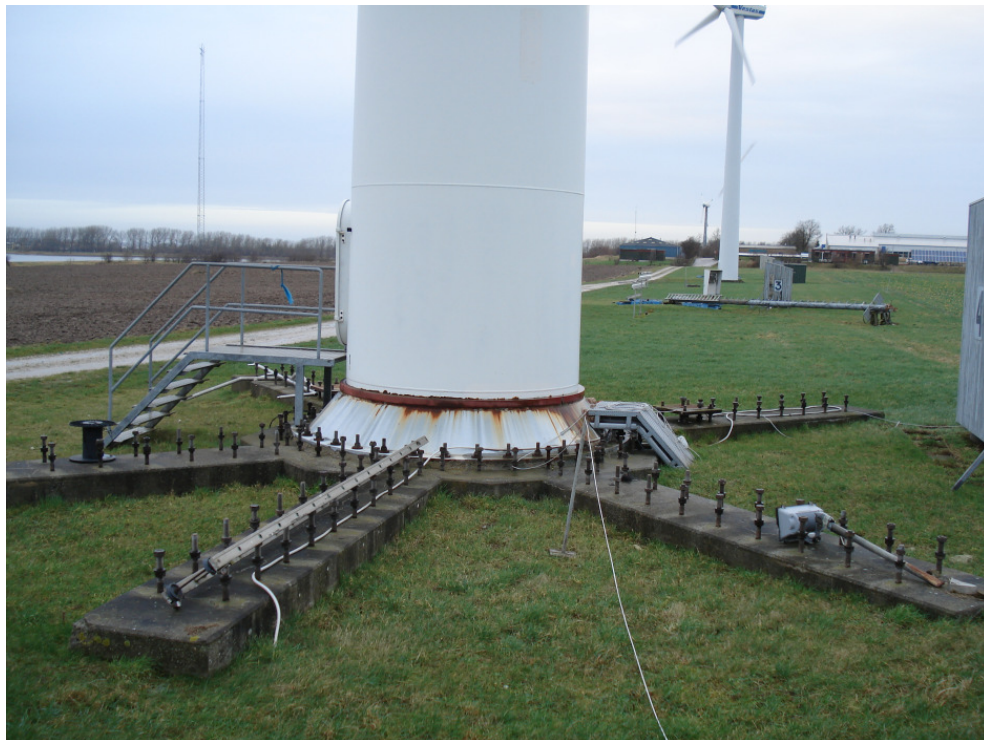
Abb. 4: Wechsel-Fundament auf der Risø Test Site in Roskilde.
