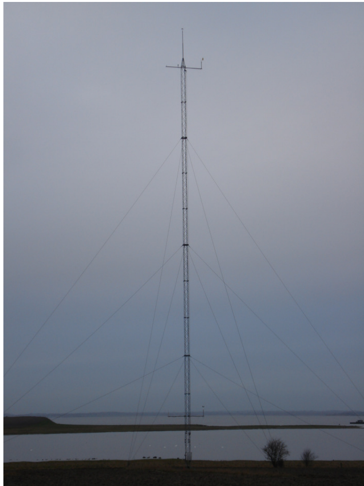
Abb. 5: Ein nach IEC-Normen und measnet-Anforderungen installierter Messmast für die Vermessung von WKA-Leistungskurven im Testfeld von Risø bei Roskilde. Das Anemometer ist an der Mastspitze ohne Blitzschutz installiert, um ein möglichst ungestörtes Windfeld messen zu können.
