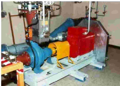
Réservoir La Risaz Turbine-pompe H = 25m P = 15kW
