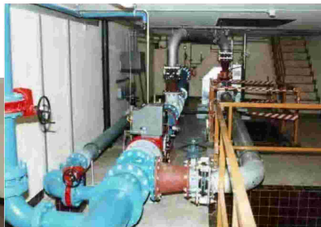
Réservoir Hautepierre Turbine-pompe H = 65m P = 35kW
