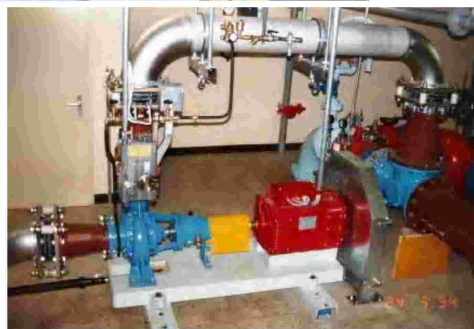
Réservoir La Risaz Turbine-pompe H = 25m P = 15kW
